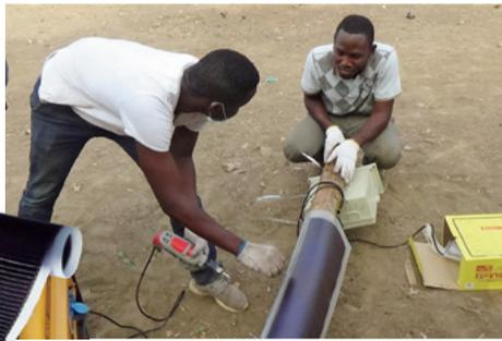
Sur la photo de gauche, un film photovoltaïque flexible. Les lampadaires avec de tels films enroulés autour de leurs poteaux introduisent non seulement de la lumière dans des zones qui auparavant manquaient d'électricité, mais jouent également un rôle dans l'amélioration de la sécurité.
