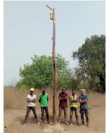
La foto de la izquierda muestra una lámina solar flexible. Las farolas con láminas de este tipo, enrolladas en sus postes, no solo introducen luz en zonas donde antes no había electricidad, sino que también contribuyen a mejorar la seguridad en esos lugares.
