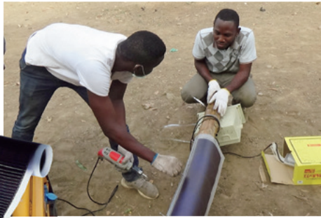
La foto de la izquierda muestra una lámina solar flexible. Las farolas con láminas de este tipo, enrolladas en sus postes, no solo introducen luz en zonas donde antes no había electricidad, sino que también contribuyen a mejorar la seguridad en esos lugares.
