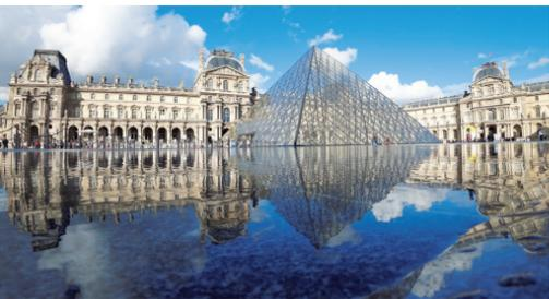
La fotocatalisis actúa con un efecto antiincrustante y antivaho simplemente por la irradiación de la luz. Ha sido usada en la pirámide de vidrio que cubre la entrada del Museo del Louvre. Al descomponer la suciedad, el vidrio mantiene su bella transparencia.
