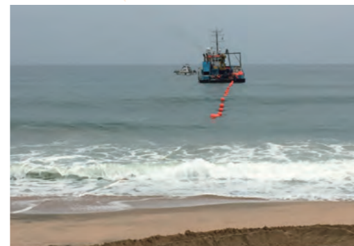
Câble vers l'Angola pendant l'installation marine
