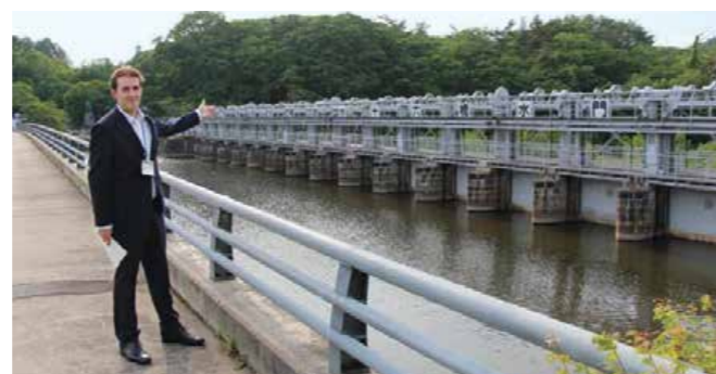
Joost devant l'écluse Jurokkyo, un élément-clé du projet de construction du canal Asaka. Cette écluse régule le niveau d'eau du lac Inawashiro tout en permettant à l'eau de s'écouler vers les plaines d'Asaka.
