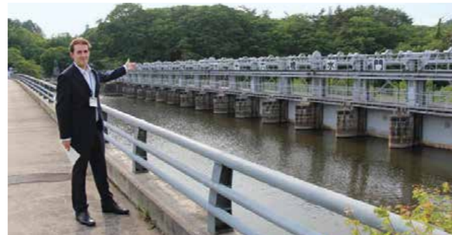
Joost frente a la esclusa de Jurokkyō, un componente clave en el proyecto de construcción del canal de Asaka. Regula el nivel del agua del lago Inawashiro permitiendo que el agua fluya hacia las llanuras de Asaka.
