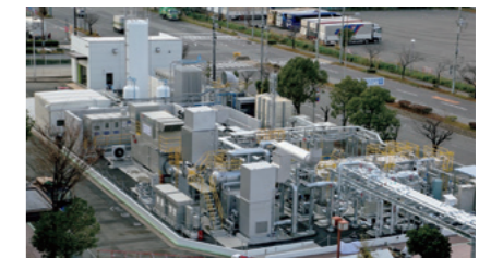
Un sistema para suministrar hidrógeno no tendrá impacto a menos que se estimule también la demanda. En abril de 2018, en el Port Island de la ciudad de Kobe las empresas Kawasaki Heavy Industries, Ltd. y Obayashi Corporation realizaron con éxito la primera demostración en el mundo de suministro de calor y electricidad a un área urbana usando una turbina de gas propulsada al cien por cien con hidrógeno.
