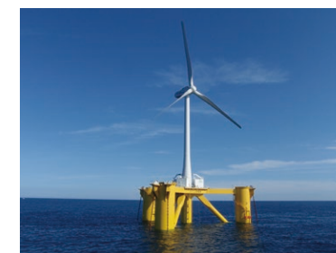
Une éolienne flottante de 7 MW a été installée au large de Fukushima grâce à un projet commandité par le ministère de l'Économie, du Commerce et de l'Industrie. Ses pales s'élèvent à une hauteur de 200 mètres au-dessus de l'océan.
