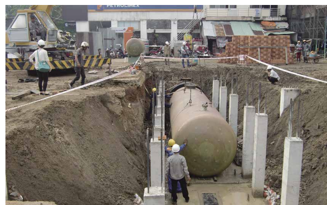
Enfouissement d'un réservoir à double paroi construit au Vietnam dans une station essence d'Hô-Chi-Minh-Ville.
