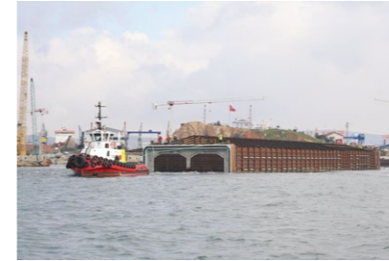
1. Barcazas utilizadas en la construcción del túnel navegando en el Bósforo, con el primer puente del Bósforo de fondo. 2. Un remolcador lleva grandes secciones de túnel de hormigón para la parte submarina del túnel al lugar de las obras. 3. Mapa de la ruta y sección transversal del túnel del estrecho del Bósforo.
