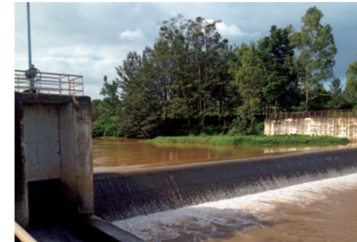
En haut : La culture des oignons fait aussi partie du programme d'irrigation des terres. En bas : Au sein du programme d'irrigation de Mwea, la construction d'un barrage et de cours d'eau avance à bon rythme, dans le cadre d'un prêt japonais de l'APD.
