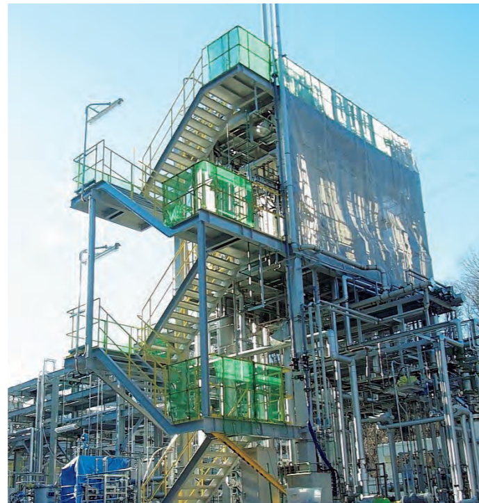
L'usine pilote construite dans un effort coopératif avec une installation de traitement de déchets à Saitama attire l'attention de pays et d'entreprises à travers le monde.
