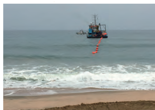
Cable a Angola durante el tendido marino.
