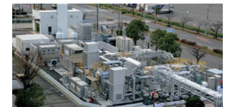
Un système de distribution d'hydrogène n'aura aucun impact si la demande n'est pas encouragée. En avril 2018, dans l'île de Port Island à Kobe, Kawasaki Heavy Industries, Ltd. et Obayashi Corporation ont mené avec succès le premier essai au monde de fourniture de chauffage et d'électricité à une zone urbaine en utilisant l'hydrogène à 100%.
