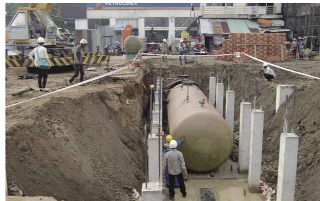
Instalación subterránea de un tanque de doble pared fabricado en Vietnam en una gasolinera de la ciudad Ho Chi Minh.
