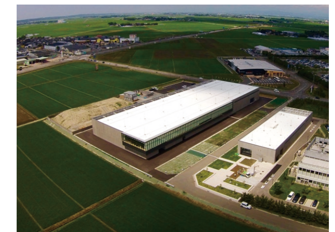
Oficinas centrales de Spiber, en un distrito rural de la ciudad de Tsuruoka (prefectura de Yamagata).
