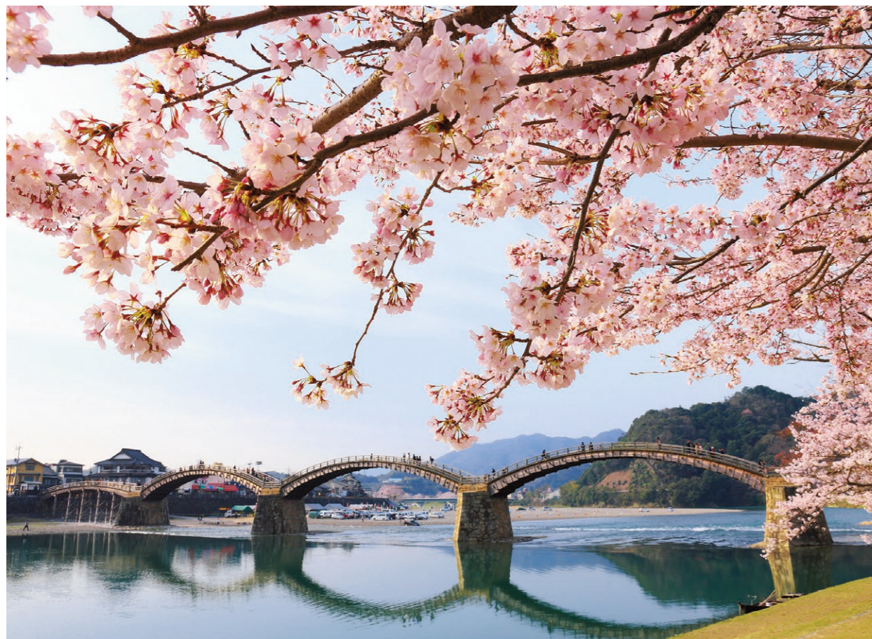
Puente Kintaikyō: Iwakuni, prefectura de Yamaguchi
