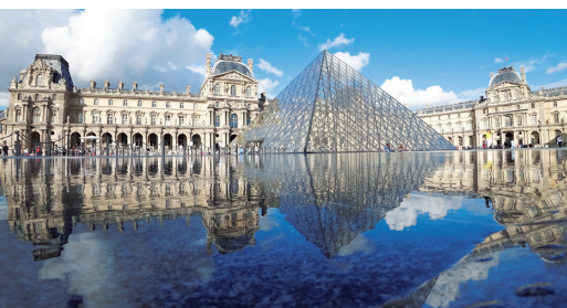
Sous l'action d'une simple source lumineuse, la photocatalyse engendre un double effet, antibuée et autonettoyant. Cette technologie a notamment été appliquée sur la verrière de la pyramide du Louvre, permettant de maintenir la transparence de l'immense surface par décomposition des impuretés.
