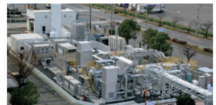
Un système de distribution d'hydrogène n'aura aucun impact si la demande n'est pas encouragée. En avril 2018, dans l'île de Port Island à Kobe, Kawasaki Heavy Industries, Ltd. et Obayashi Corporation ont mené avec succès le premier essai au monde de fourniture de chauffage et d'électricité à une zone urbaine en utilisant l'hydrogène à 100%.
