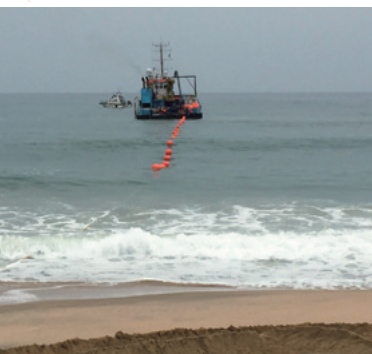
Câble vers l'Angola pendant l'installation marine
