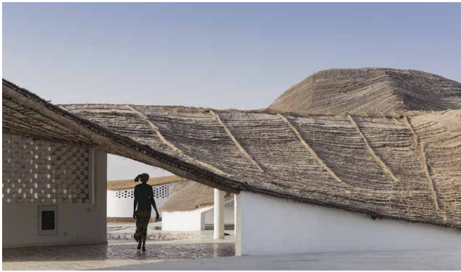
Construido con techo de paja, ladrillos de barro secados al sol y bambú, el centro se erigió con materiales y mano de obra locales. Su característica definitoria es un techo de paja inclinado que recoge la lluvia, que sirve para cubrir casi el 30 % de las necesidades domésticas de la aldea. © Iwan Baan
