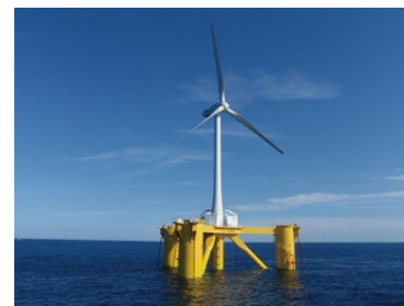
Una turbina eólica flotante de siete megavatios ha sido construida frente a las costas de Fukushima, como parte de un proyecto promovido por el Ministerio de Economía, Comercio e Industria. Las aspas alcanzan una altura de 200 metros sobre el mar. Fotografía: Consorcio Eólico Marítimo de Fukushima.
