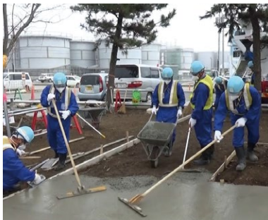
Gracias a esfuerzos de descontaminación de la central ya no es obligatorio llevar trajes completos de seguridad ni máscaras en el 90 % del área de la instalación. Fotografía: Tokyo Electric Power Company Holdings, Inc.
