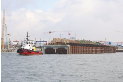
1. Barcasas utilizadas en la construcción del túnel navegando en el Bósforo, con el primer puente del Bósforo de fondo. 2. Un remolcador lleva grandes secciones de túnel de hormigón para la parte submarina del túnel al lugar de las obras. 3. Mapa de la ruta y sección transversal del túnel del estrecho del Bósforo.
