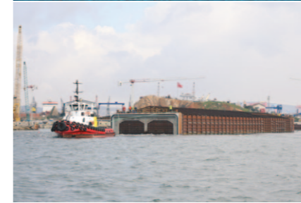
1. Ces plateformes flottant sur le Bosphore sont destinées à la construction du tunnel ; à l'arrière-plan, on distingue le premier pont traversant le détroit. 2. Ces grandes sections de tunnel en béton destinées à la partie immergée ont été remorquées jusqu'au site. 3. Tracé et vue en coupe du tunnel du détroit du Bosphore.
