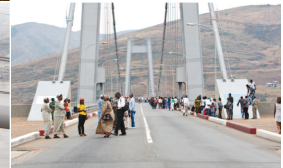
1. Le pont Matadi en République démocratique du Congo. L'ouvrage est conçu comme un pont mixte rail-route, avec une voie ferrée passant sous la route. (© Shinichi Kuno/JICA) 2. Employés de l'OEBK occupés à l'entretien du pont. De mars 2012 à mars 2015, le Japon s'est impliqué dans un projet de soutien au perfectionnement des compétences en matière de gestion des ponts. (© Shinichi Kuno/JICA) 3. Le pont Matadi est devenu une attraction pour les touristes, qui apprécient la grâce et la robustesse de ce pont à haubans, ainsi que les vues qu'il offre sur le puissant fleuve Congo qui s'écoule en dessous. (© Shinichi Kuno/JICA)
